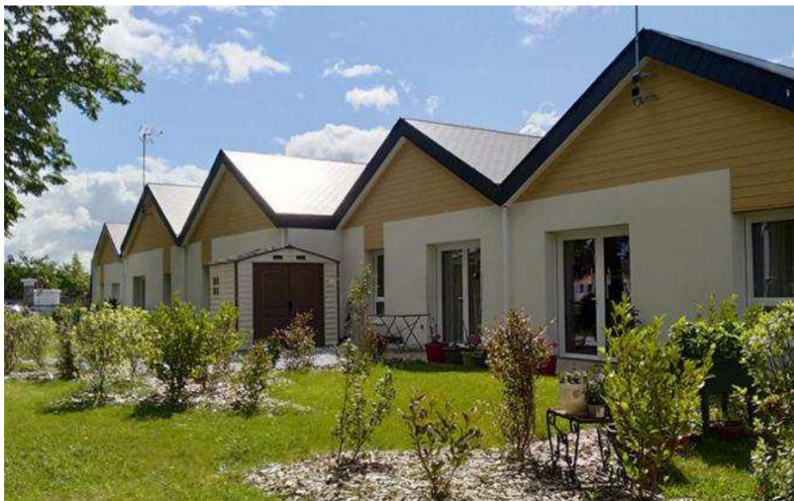
▲ Un béguinage construit par Vivr'Alliance à Murs, dans le Vaucluse. — Photo : Vivr'Alliance
